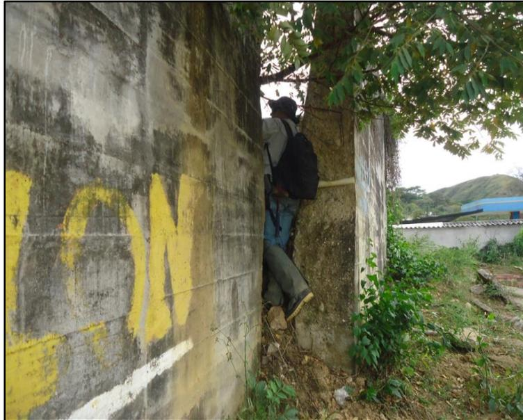
**Ilustración 288 Separación del muro de contención de la cancha de aproximadamente 70 cm.
