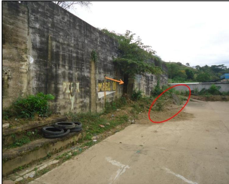
**Ilustración 159. Deslizamiento rotacional.**
