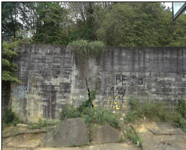
**Ilustración 289. Separación del muro de contención de la cancha de aproximadamente 70 cm.
