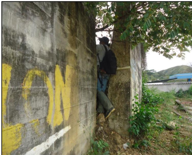
**Ilustración 160. Separación del muro de contención de la cancha de aproximadamente 70 cm.**
