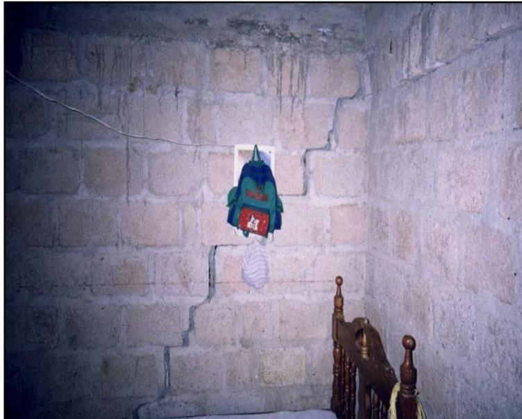
**Ilustración 3. Grietas en los muros de la vivienda de Tino Becerra Silva en el barrio Las Brisas. Fuente: (CAM Idea - UN, 1999)**
