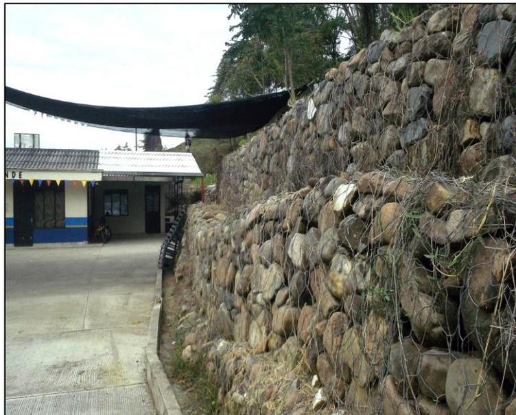
**Ilustración 277. Deformación de los gaviones en la parte inferior del deslizamiento. Fuente: Geocing SAS.**
