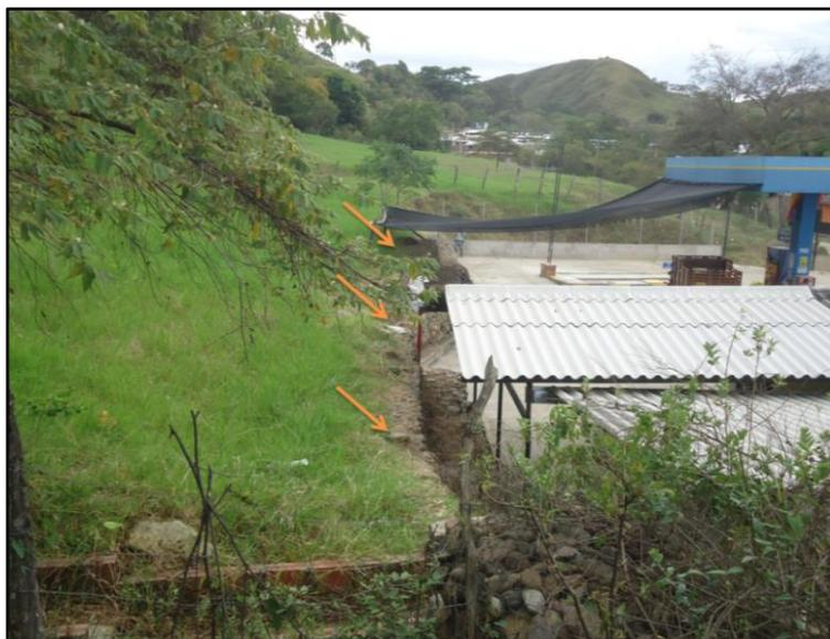
**Ilustración 57. Coordenadas: E=1167803, N=796125, N. Deformación de los gaviones en la parte inferior del deslizamiento. Fuente: Geocing SAS.**
