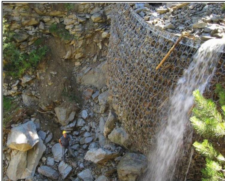
**Ilustración 327. Malla geodinámica**
