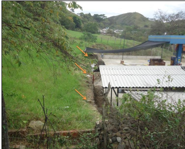
**Ilustración 276. Coordenadas: E=1167803, N=796125, N. Deformación de los gaviones en la parte inferior del deslizamiento, lo que indica el depósito del material desprendido de la parte superior. Fuente: Geocing SAS.**
