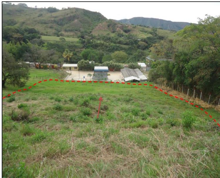
**Ilustración 275. Coordenadas: E=1168050, N=795655, E. Deslizamiento rotacional en la ladera contigua a una estación de gasolina a la entrada del municipio de Teruel.**
