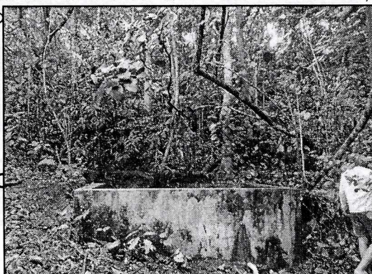
Estructura en donde se capta el agua que aflora.
