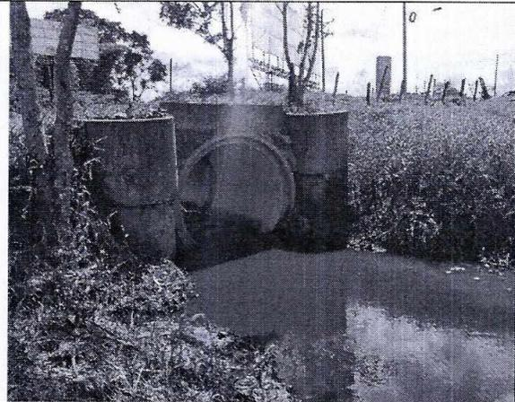
*Fotografía 3. Canalización y punto de aforo*
