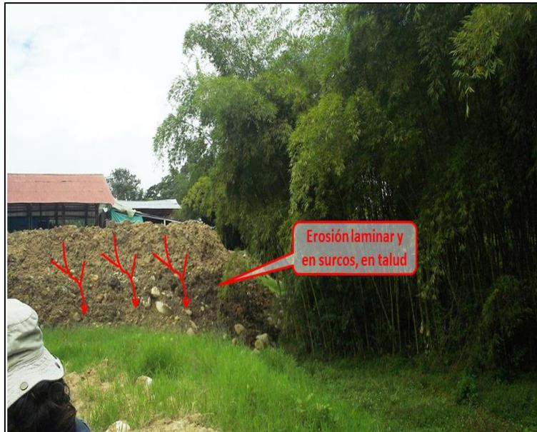
**Ilustración 44. Coordenadas. E= 1132280, N= 690821, orientación al suroccidente. Erosión laminar y en surcos, en talud en depósito antrópico.**
