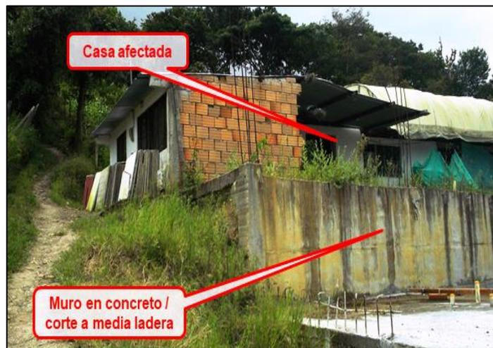
Ilustración 32. Coordenadas. E= 1131780, N= 691265, orientación al norte. Vivienda afectada por inestabilidad generada por corte a media ladera. Fuente: Geocing S.A.S.
