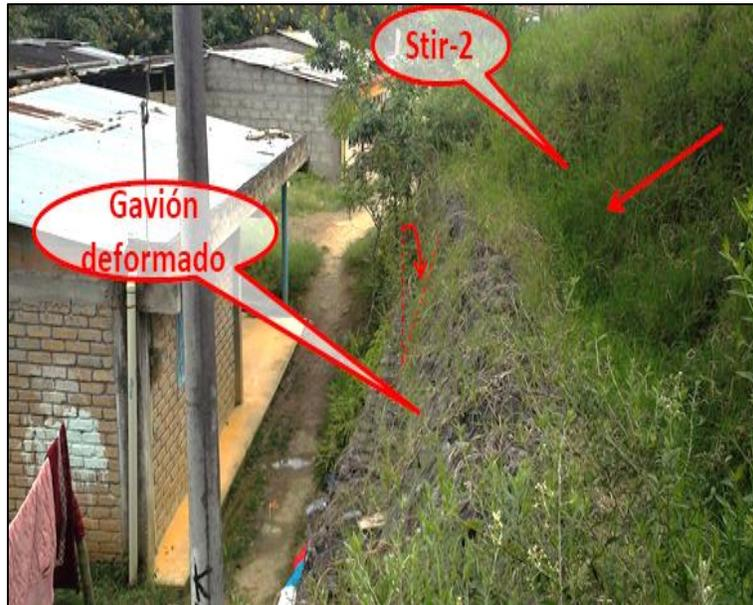
Ilustración 17. Coordenadas: E= 1132367, N= 691595, orientación al oriente. Se observa deformidad en gaviones por movimiento en dirección aproximada suroriente.
